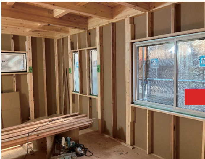
外壁面には80mmの断熱材を吹き付けます
