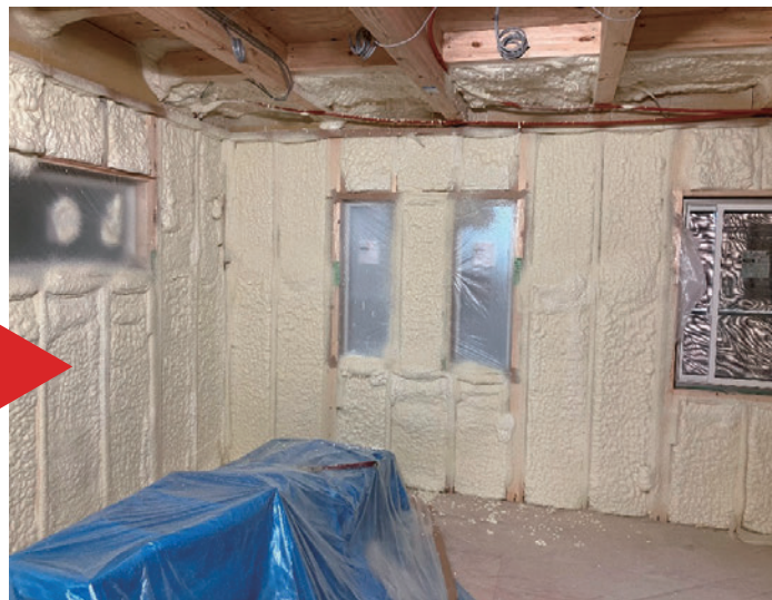
外壁面には80mmの断熱材を吹き付けます
