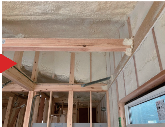
屋根裏には160mm断熱材を吹き付けます
