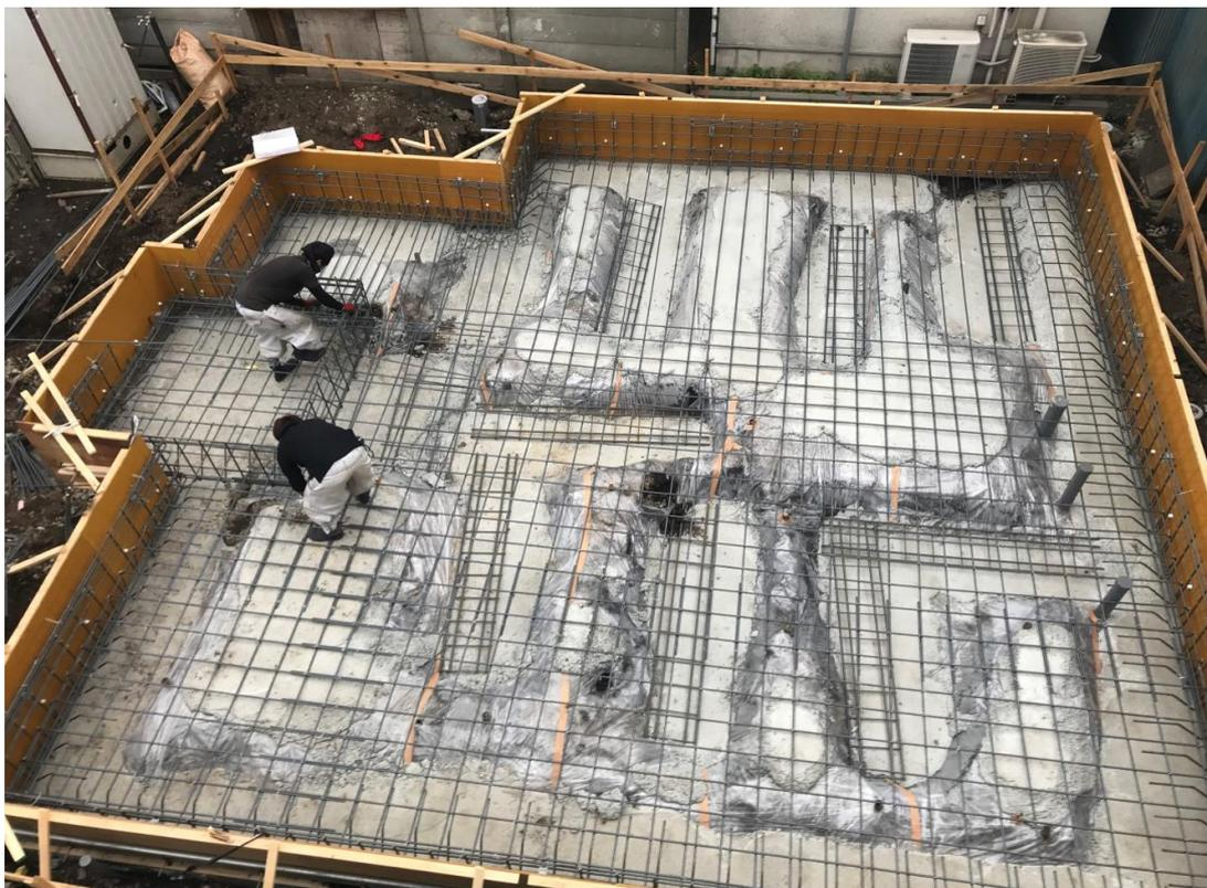
基礎には配筋と言われる鉄筋が入っており、一定のピッチで正確に施工します。
