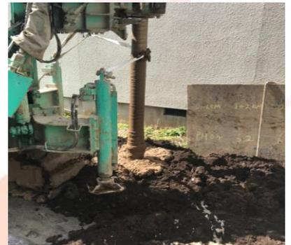
セメント系の固化材と対象の土を攪拌して地盤内に改良柱体を造り基礎を支えます。
