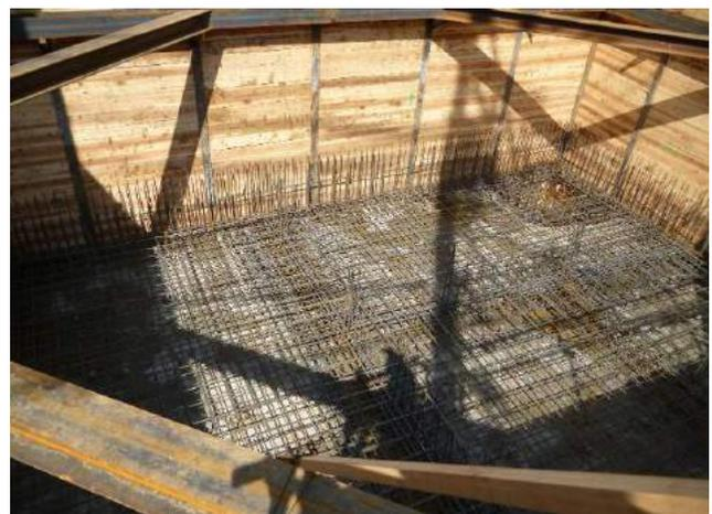
掘削作業が終了したあとは配筋作業を進めていきます。
