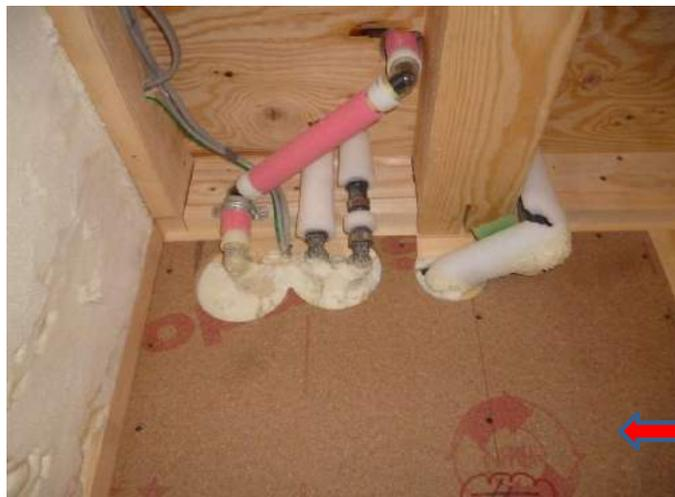
配管周りも隙間なく断熱施工してあります。この部分を疎かにしてしまうと、中途半端な隙間から結露が発生し、カビを生み、やがてはシックハウスとなってしまいます。
